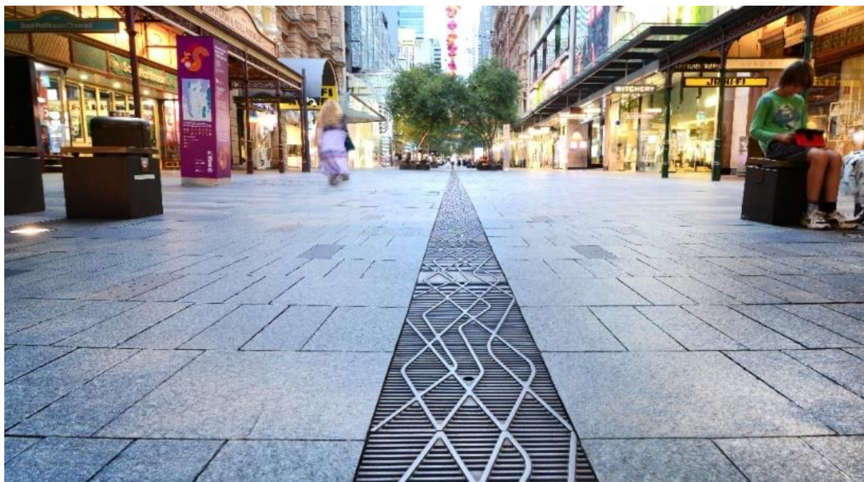
Figură 5-15 Model orientativ de dispunere rigola carosabilă cu capac din fontă cu design architectural pe străzi pietonale
